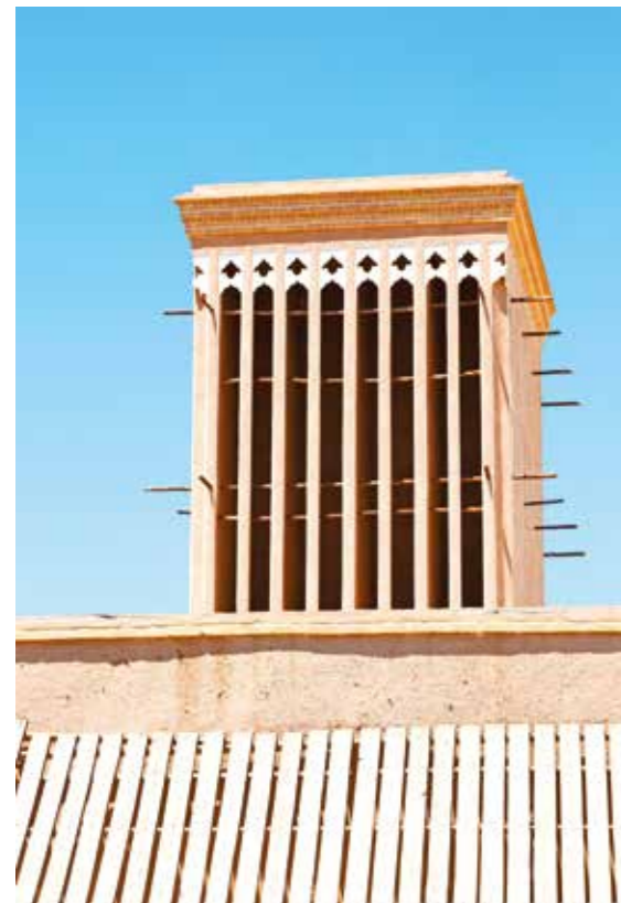
Dans la recherche d'un refroidissement sans émissions, l'ingénieuse méthode des tours à vent pourrait à nouveau servir.
